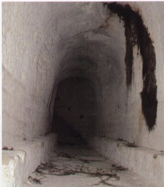
L'ampia galleria scavata nel tufo. Su entrambi i lati sono stati realizzati i sedili per i cittadini che si rifugiavano in caso di bombardamenti
